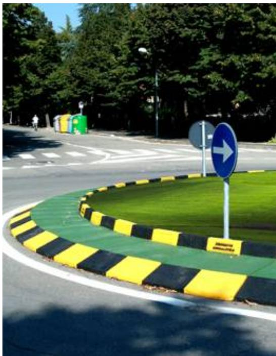
Rotatoria modulare per incroci, composta da elementi in plastica eterogenea riciclata ad elevata resistenza.
